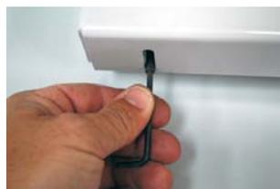
Refermer le couvercle supérieur. Visser les deux vis pointeau en les laissant dépasser d'environ 3 mm de la platine supérieure.
